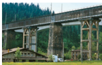
Viaducto del ferrocarril, Ormaiztegi
