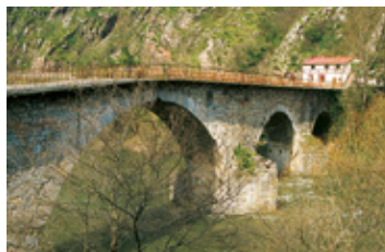
Puente de Peñaflor
